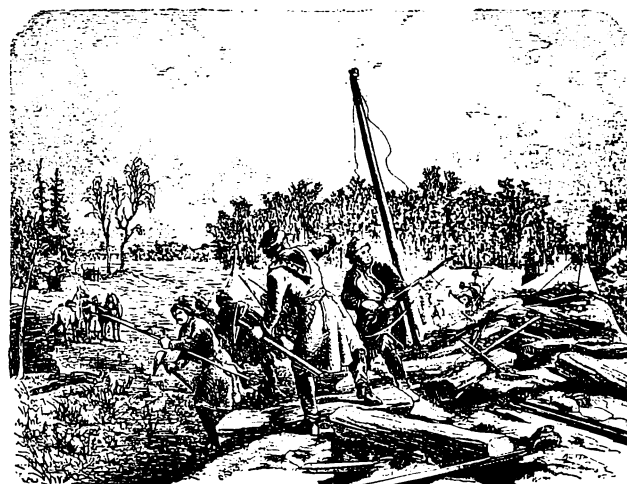
Разрушеніе желѣзной дороги повстанцами.
